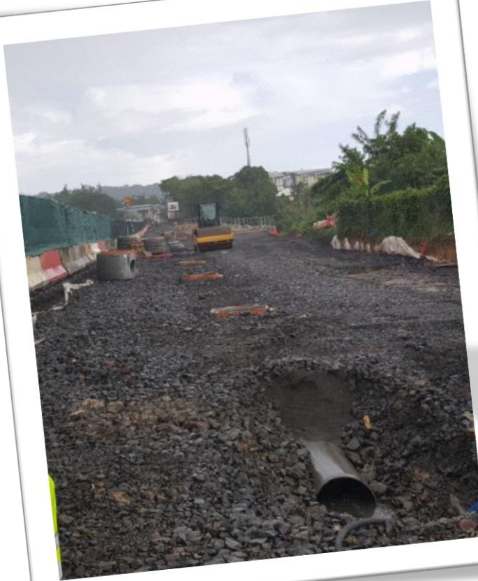
Mise à 2x2 voies RN1 Mansarde/Maternité
