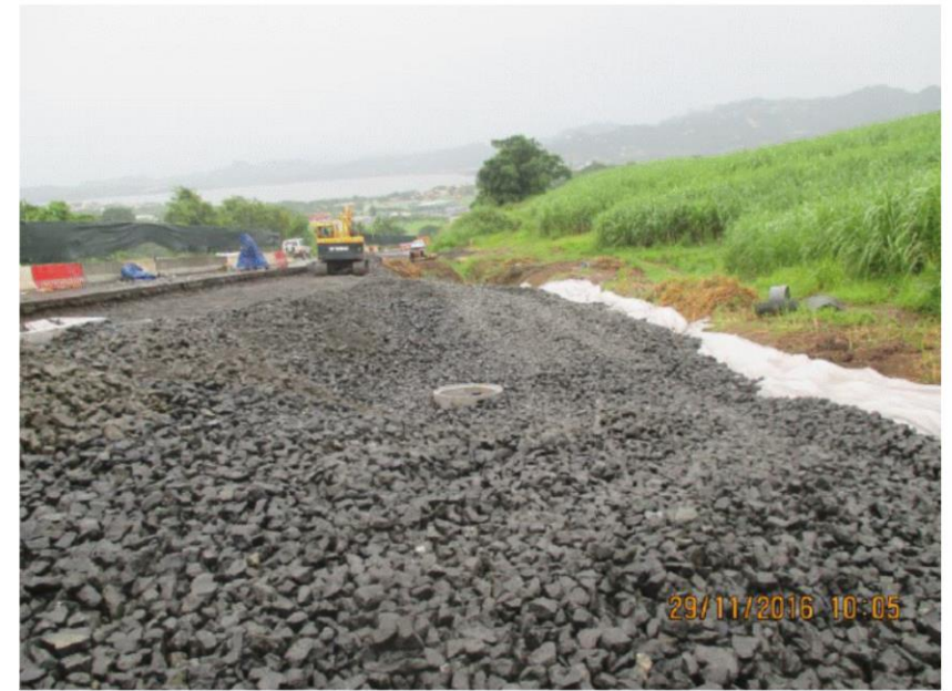
Mise à 2x2 voies RN1 Gaschette/Lestrade
